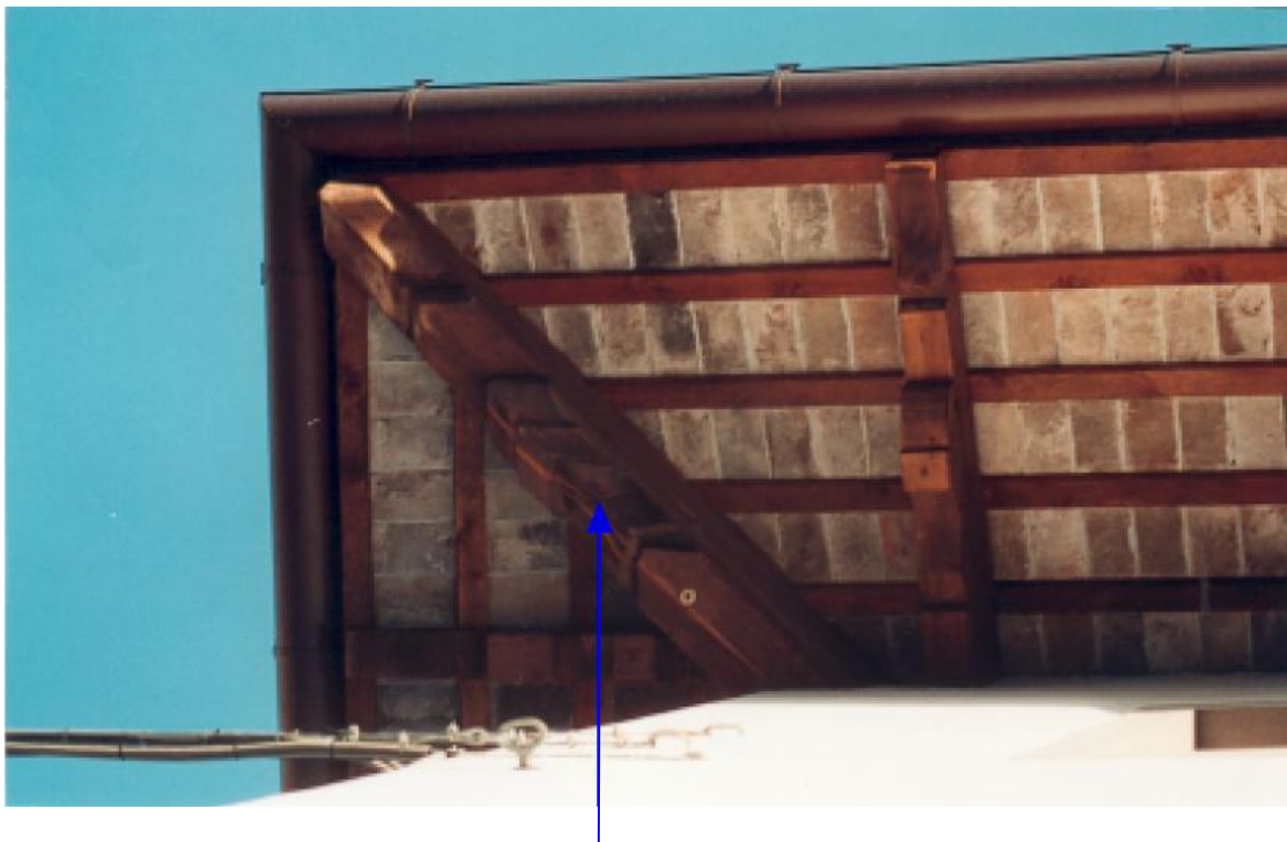
Struttura di copertura a vista in legno e laterizio .
