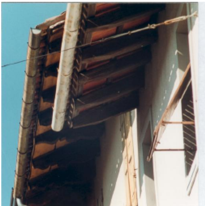
Struttura di copertura a vista in legno e laterizio .
